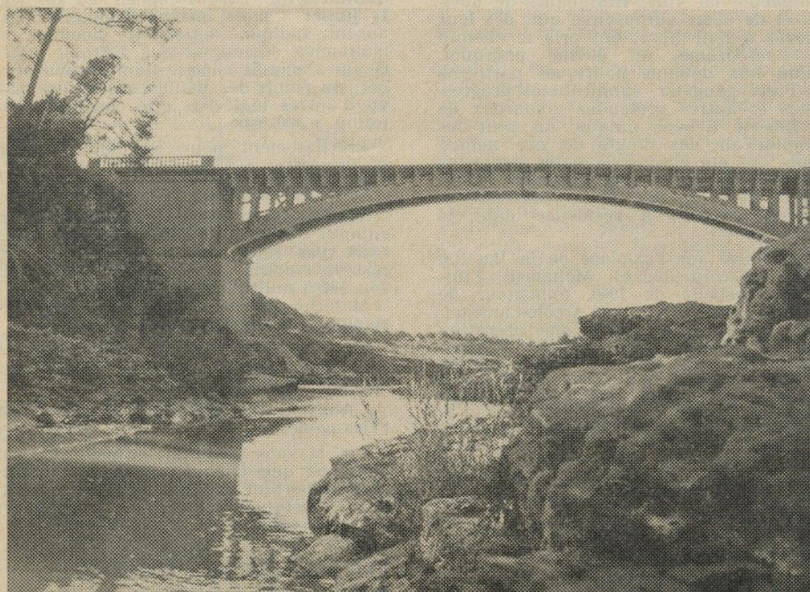
Le Pont construit par le Génie en 1869
