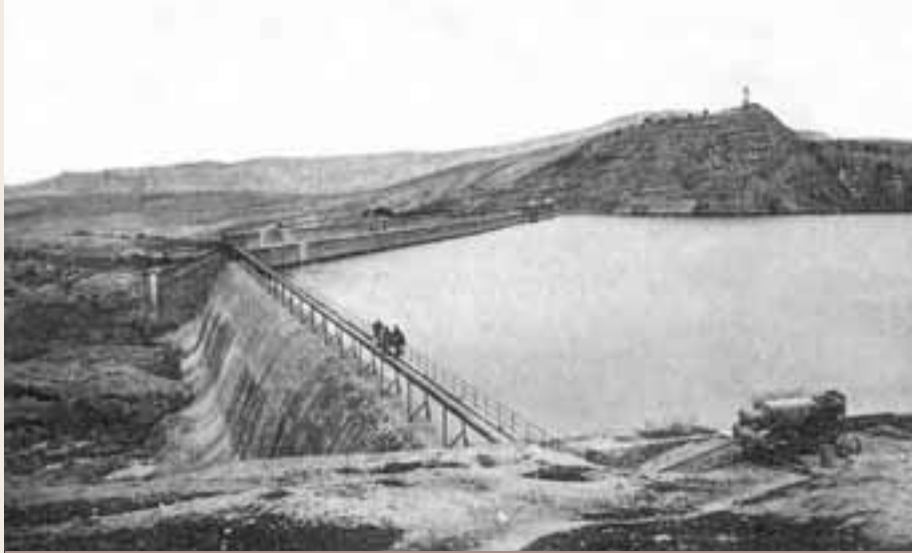
Le barrage avant sa rupture du 26 novembre 1927 (document Joseph Sellès)
